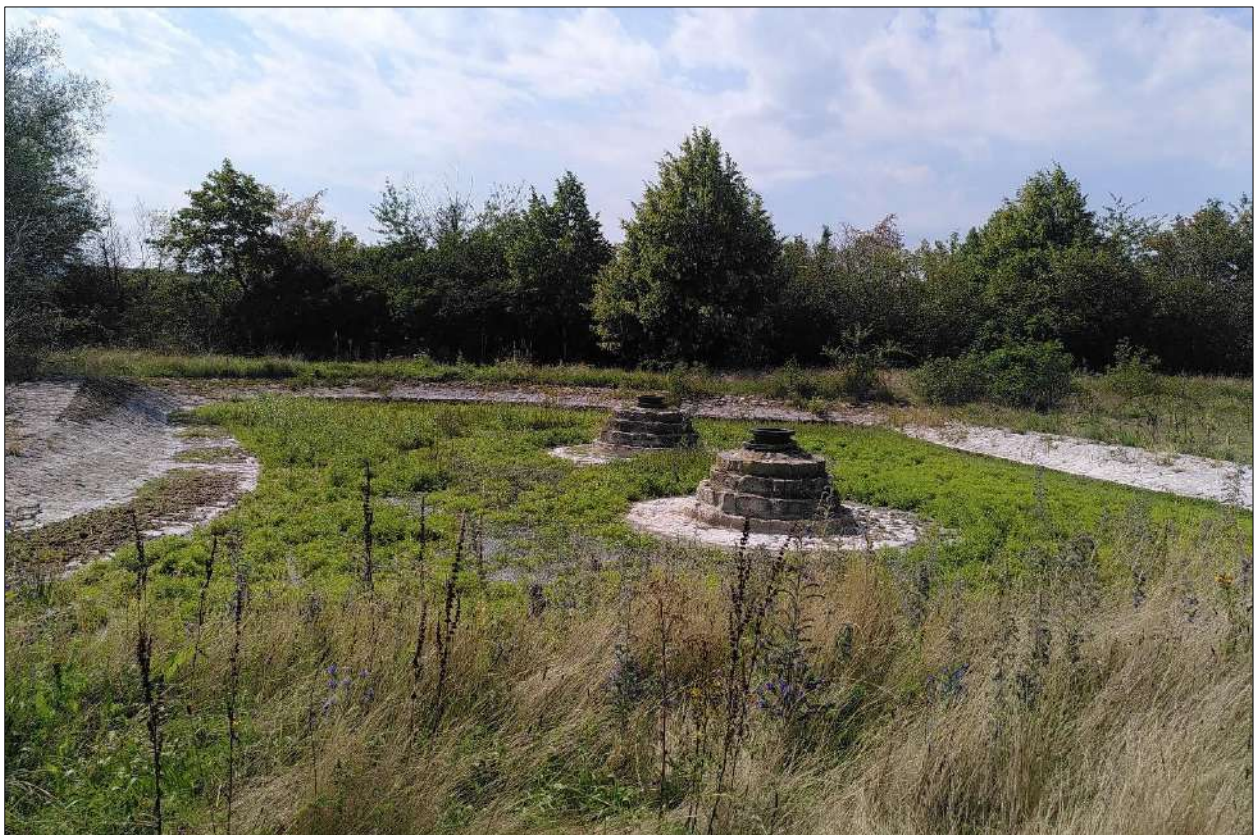
Abbildung 6: Betonbecken im Westen des Untersuchungsgebiets (IBU 08/2023).
