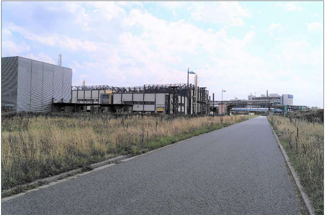
Abbildung 4: Blick nach Südwesten auf eine interne Erschließungsstraße und Industriebauten (IBU 05/2023)
