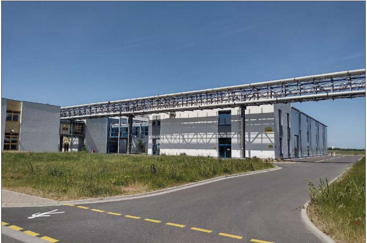
Abbildung 7: Blick nach Norden auf Verkehrsflächen und Industriebauten (IBU 05/2023).
